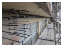
補強用アンカーボルト
