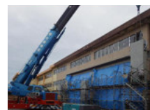
補強用柱の建込み
