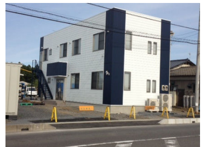
茨城町 横須賀機材 事務所新築工事
