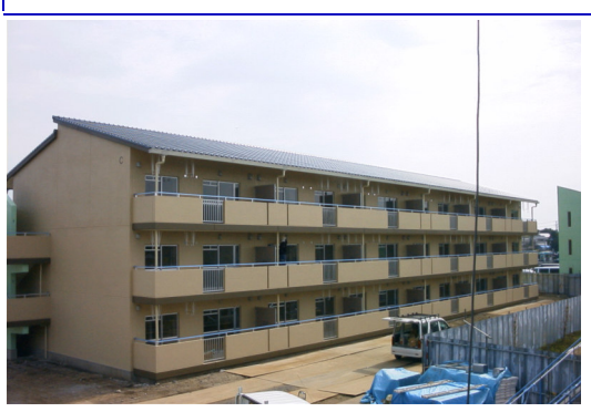
H16年5月竣工 大洗町 担当 町営二葉住宅第3工区建設工事 小野瀬 勝豊
