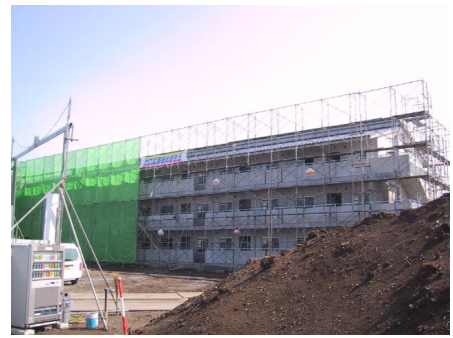
H15 大洗町 町営二葉住宅第3工区建設工事
