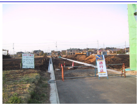
H15 那珂町 竹之内区画整理道路改良工事
